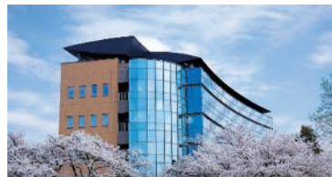
▶ 提案した研修ホール改修を実現コロンパ対策に貢献しました
